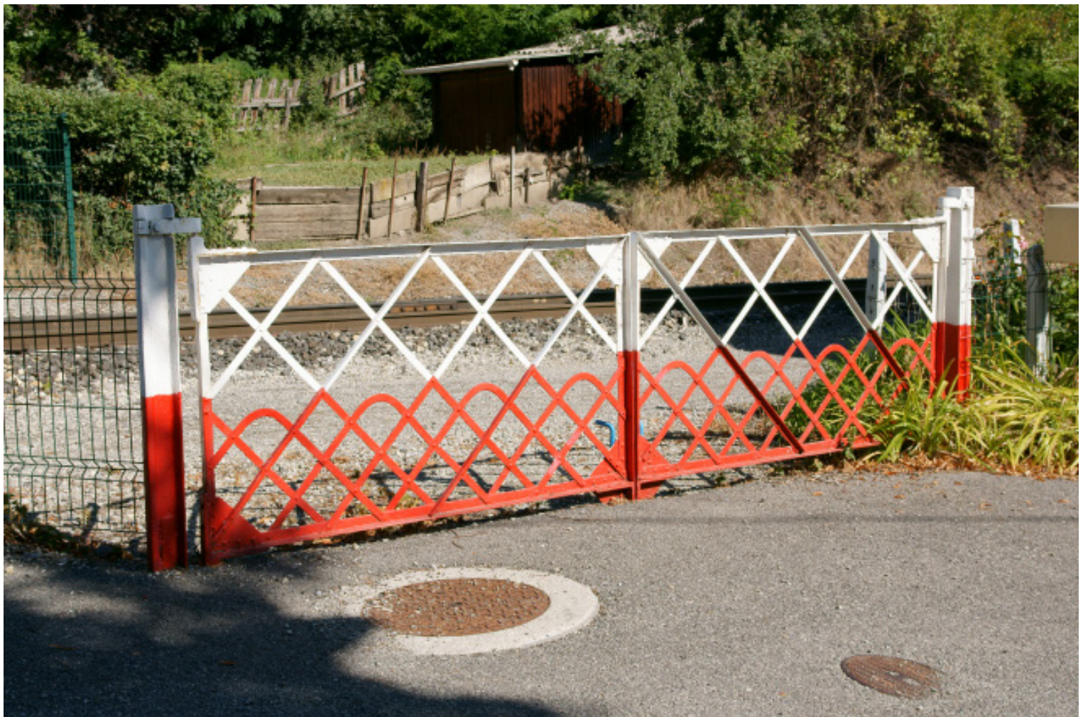
Barrières réelles implantées à proximité de Gap.
