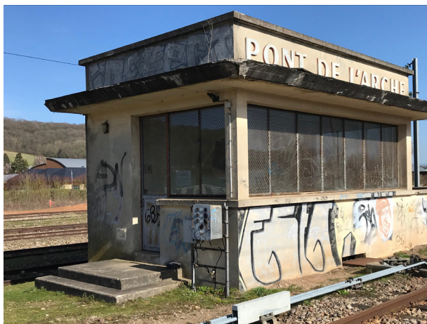
Vue extérieure du poste d'aiguillage de Pont de l'Arche.
