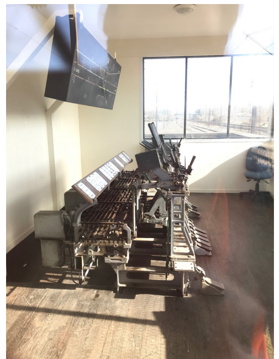
Vue intérieure du poste d'aiguillage de Pont de l'Arche.
